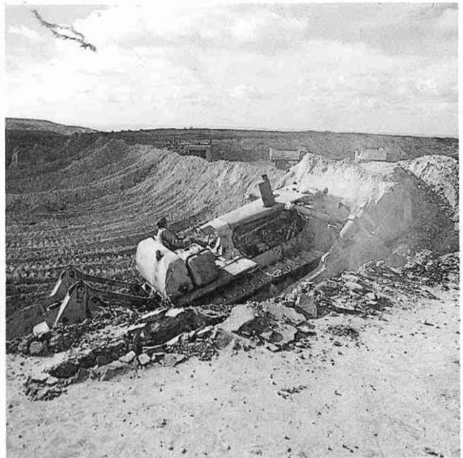
Detalle de movimiento de tierras.
